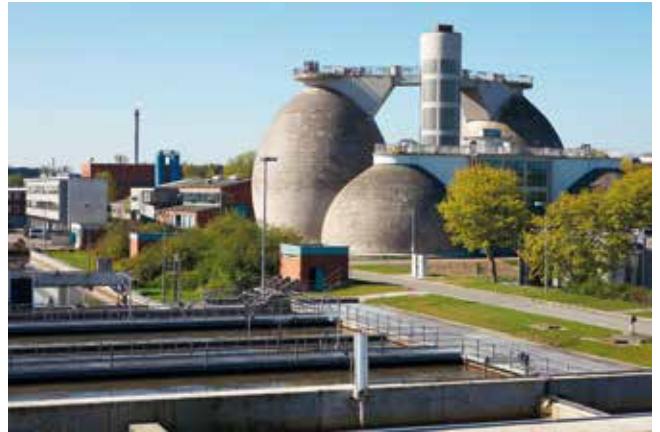
In den großen Faultürmen wird aus dem Klärschlamm Biogas gewonnen. 20 Mio. m 3 Abwasser werden jährlich im ZKW gereinigt.
