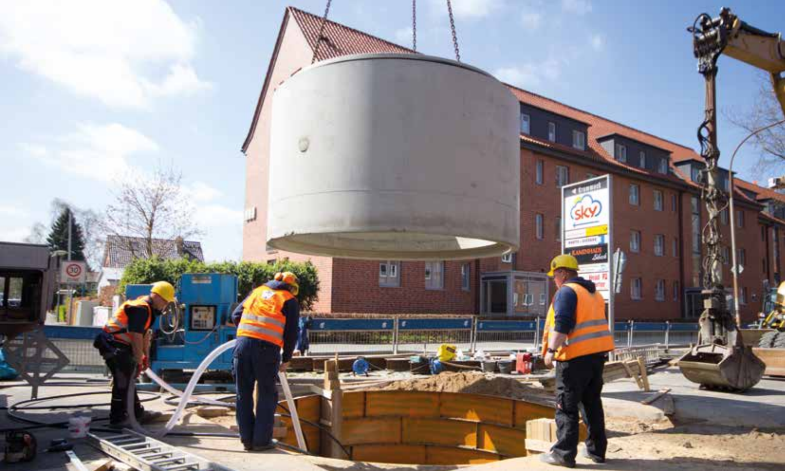
■ Nicht alle Baumaßnahmen in Lübeck werden so umfangreich sein, wie zum Beispiel hier in der Ratzeburger Allee.
