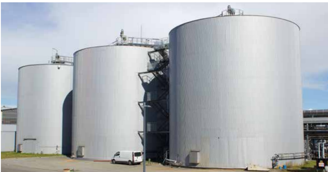
■ Die großen Bioreaktoren prägen die Außenansicht der MBA
